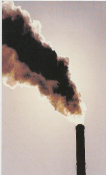
....macht die Energieversorgung sicherer
