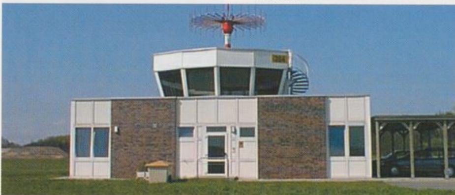
Landebahnbeobachtungshaus am Flughafen Hamburg - Fuhlsbüttel
