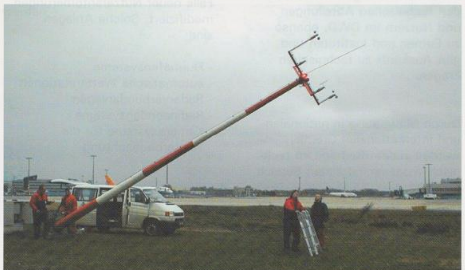
Wartungsarbeiten an einem Windmast
