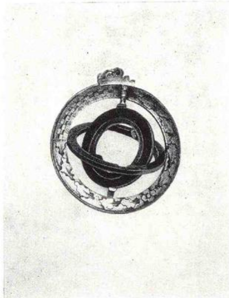
Abb. 40. Ringsonnenuhr, etwa 17./18. Jh., auseinandergeklappt
