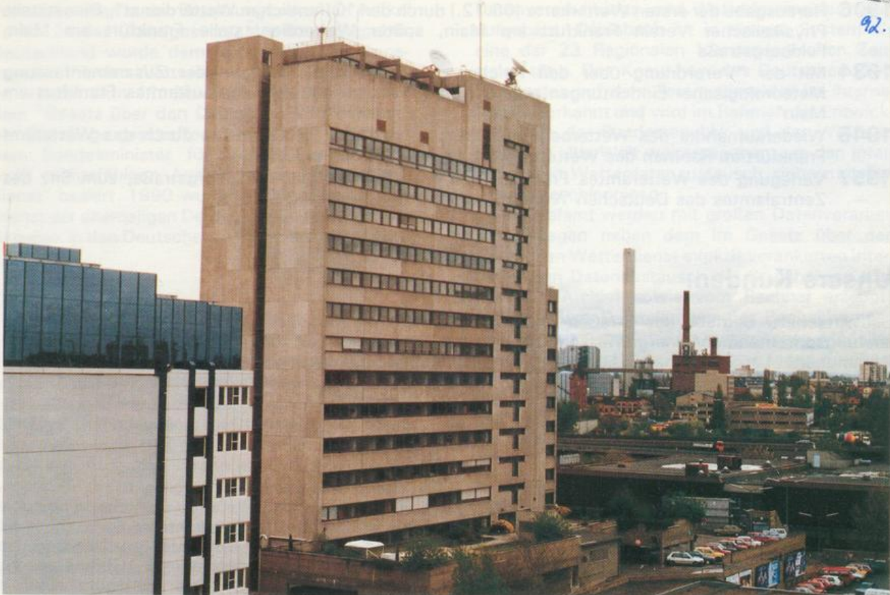
Das Zentralamtsgebäude mit dem Wetteramt Frankfurt in Offenbach a. M., Kaiserleistraße 42
