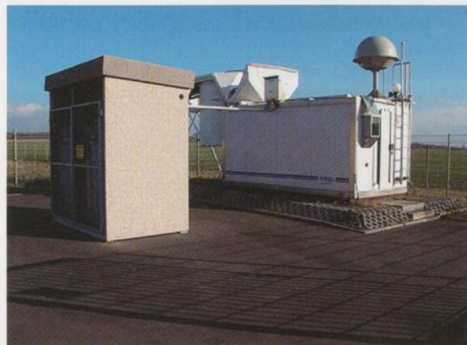
Außenansicht einer automatischen Radiosondenstation
