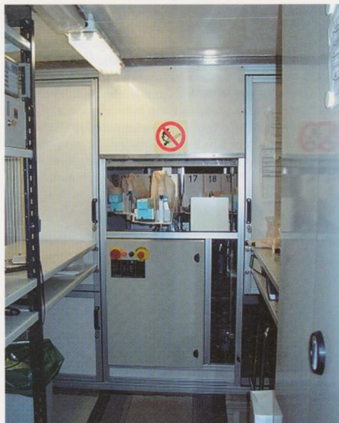
Innenansicht einer automatischen Radiosondenstation
