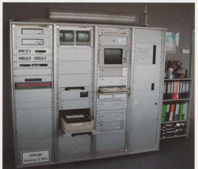
Vorderansicht eines mikroprozessorgesteuerten Registriersystems zur Erfassung Meteorologischer Daten
