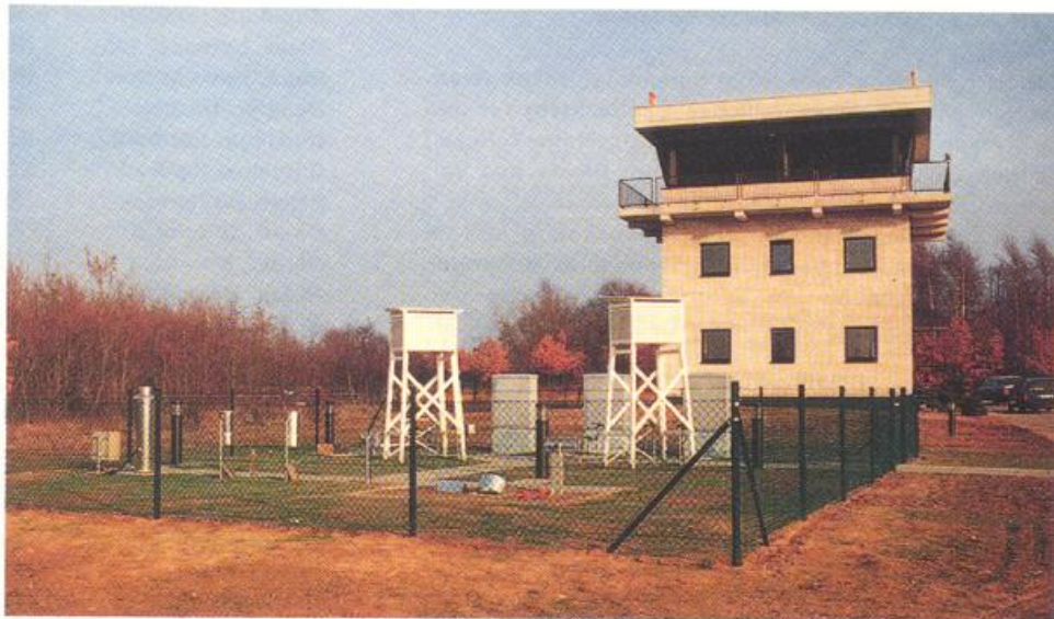
Abb. 3: Neues Landebahn- beobachtungshaus am Flughafen Köln/Bonn.
