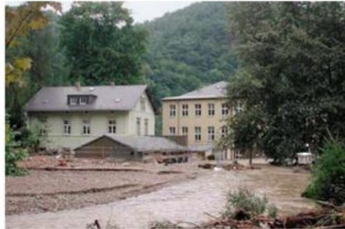
Abb. 2: Überflutetes Tal der Wilden Weißeritz in Tharandt am 14.08.2002. Vordergrund: Meteorologisches Messfeld, rechts die umströmte Klimahütte, links Institutsgebäude. Hintergrund: Cotta-Bau (TU Dresden, Fachrichtung Forstwesen). Foto: U. Eichelmann.
