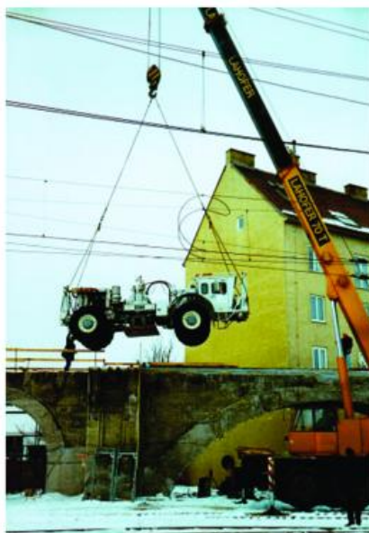
Abb. 4: VibroScan®-Einsatz an alten Viadukten einer Bahnverbindung in Wien
