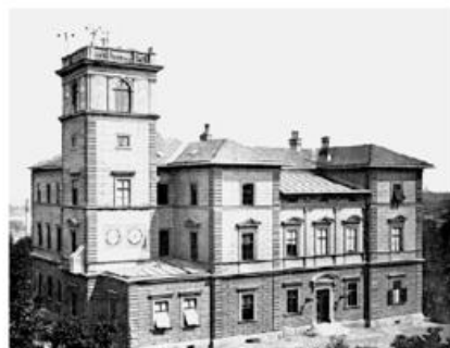
Abb. 1: ZAMG – historisches Gebäude (HANN-Haus)
