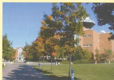
Die markante Wetterbeobachtungskanzel wurde zum weithin sichtbaren Wahrzeichen des neuen Bildungs- und Tagungszentrums des DWD in Langen. The distinctive weather observation tower has become the landmark of the new Meteorological Training and Conference Centre of the DWD in Langen.
