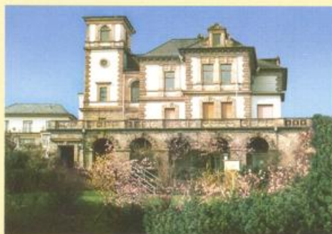
Die alte Wetterdienstschule in Neustadt an der Weinstraße im Stil italienischer Renaissance-Landhäuser The old "Wetterdienstschule" (Meteorological Training Centre) in Neustadt an der Weinstraße, built in the style of an Italian Renaissance country house
