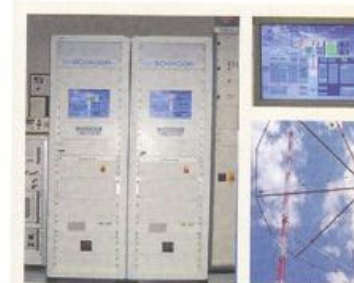
Wetter- und Warnfunk des DWD für Schiffe auf See: Das Foto zeigt die Senderschranke, einen Bildschirm-ausschnitt des Steuerungsdiskreits und die Langwellen-Antenne der Wetterfunkstation Pinneberg.
