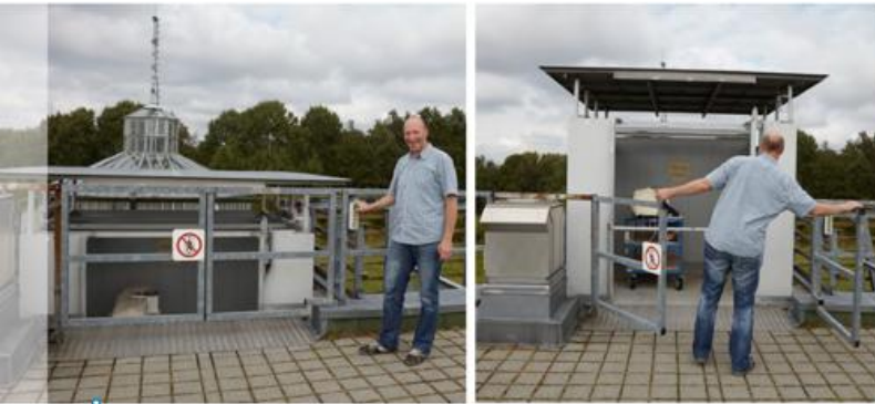
Ingo Ortman am Lastenaufzug auf dem Dach der SMZ – gleich wird das Dobson-Spektrophotometer auf seine Messposition geschoben.
