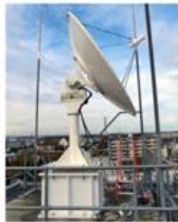
^ Neue X-/L-Band-Antenne mit Blitzschutz Quelle: DWD
