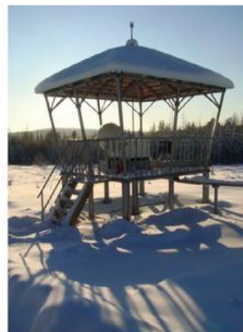
Radionuklidmessstation RN56 Peleduy, Russische Föderation. Quelle
