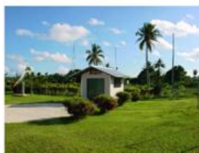
Radionuklidmessstation RN51 Kavieng, Papua-Neuguinea. Quelle
