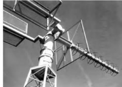
Mit dieser so genannten Wendel-Antenne wurden Ende der 1960er Jahre die ersten Satellitenbilder beim DWD in Offenbach empfangen. // Quelle: DWD
