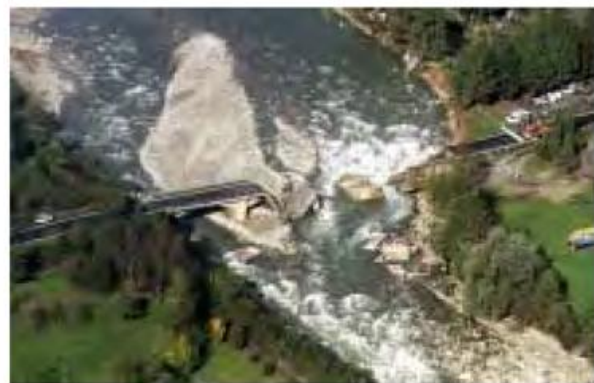
Abb. 2 Luftaufnahme der eingestürzten Brücke 'Ponte Sul Sangone', Giaveno, Provinz Turin (Italien) vom Oktober 2000 (Foto: http://www.provincia.torino.it/emergenza/ )
