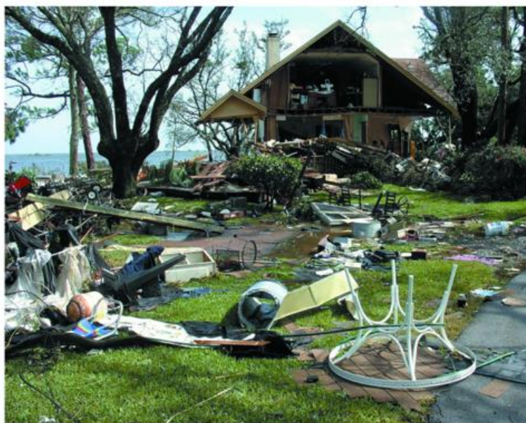
Abb. 4 Zerstörungen durch Hurrikan Katrina (Photo: A. Burton, 2005)
