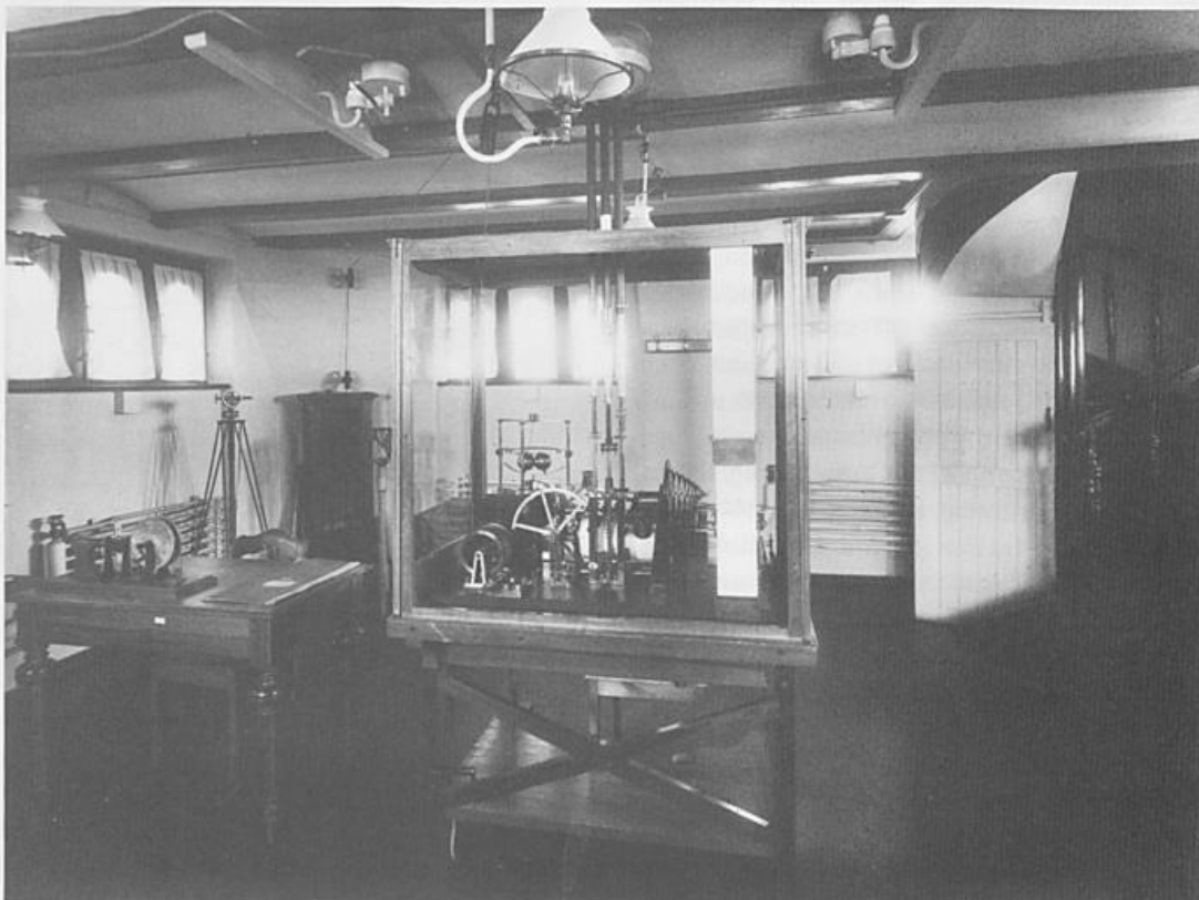
Abb. 22: Registrierraum unterhalb der Turmplattform mit dem Registrierteil der Windmeßanlage
