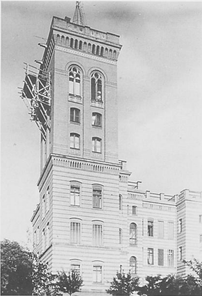
Abb. 7: Meteorologisches Observatorium, Bauarbeiten am Turm (Nordseite) um 1901, von Nordwesten aus gesehen
