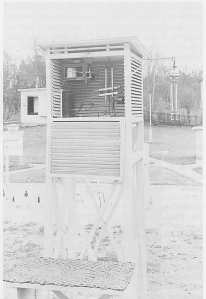
Abb. 14: Thermometerhütte auf der Beobachtungswiese, mit angehängtem Assmannschem Aspirationspsychrometer (1912)
