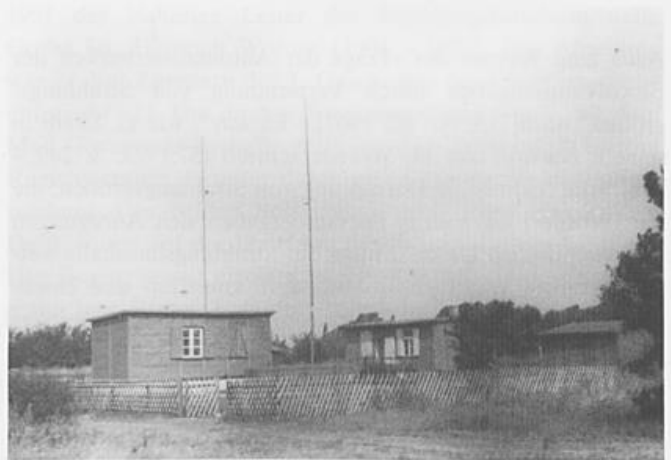
Abb. 31: Außenstelle Schlaatz, Peilbaracken (um 1960)
