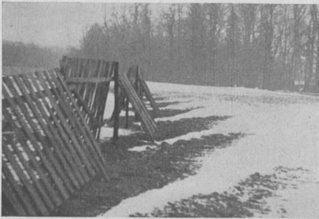
Abb. 27 Schneeablagerung bei schräg zur versetzten Holzhürde anstehendem Wind
