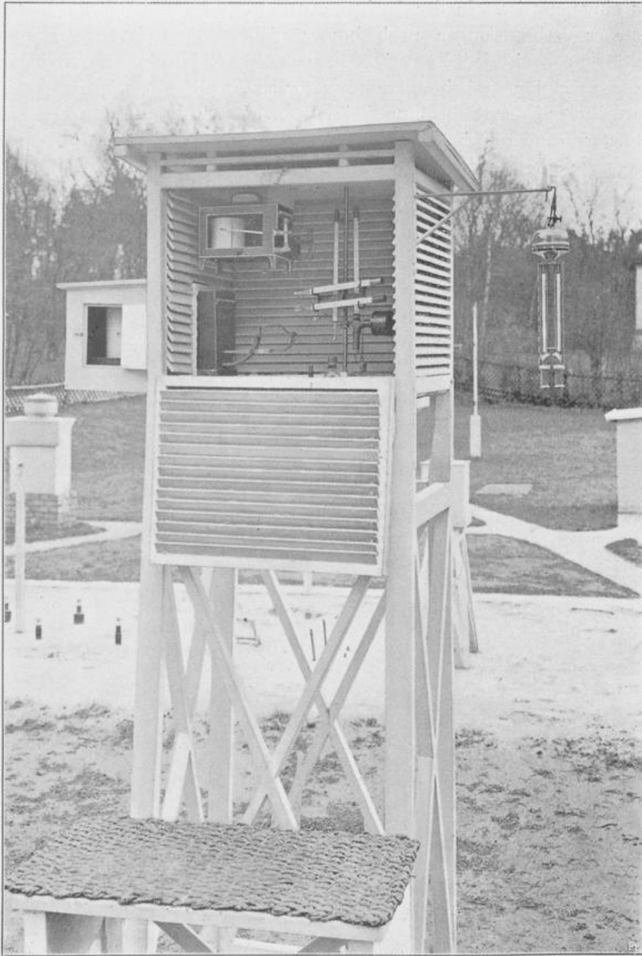
Abb. 12: Blick in die offene Wetterhütte. Links im Anbau der Thermograph, dessen Meßfühler in die Wetterhütte hineinragt. (Quelle: wie Abb. 11)
