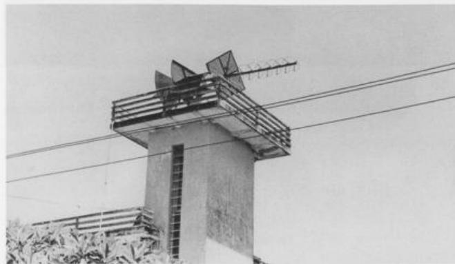
Abb. 12.10: Aufbau der Wettersatelliten-Empfangsanlage WES-1 in Đa Nãng/Vietnam
