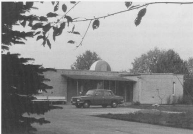
Abb. 12.8: Gebäude der Forschungsstation Zingst mit Radar- und Empfangsstation (unter der Kuppel) zur Messung von Wind- und Temperaturdaten aus der Hochatmosphäre
