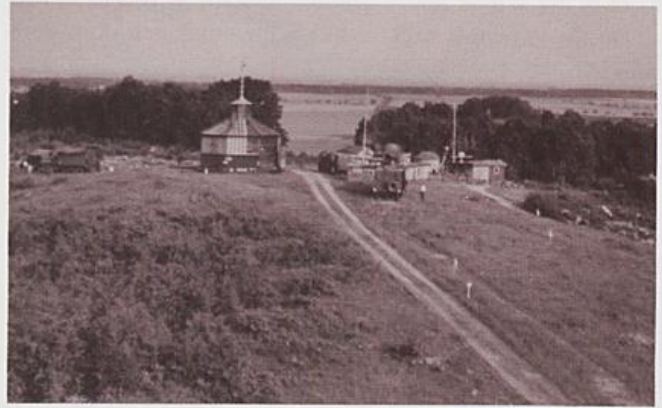
Abb. 1.3: Windenhaus mit der Messzentrale (rechts) um 1968
