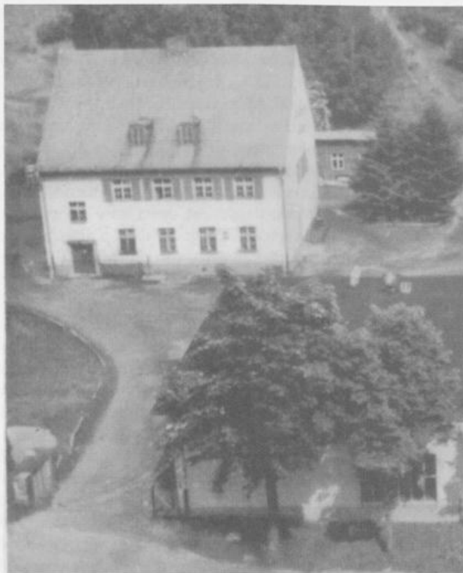
Abb. 6.1: Unter Koschmieders Leitung entstand ein neues, modern eingerichtetes Laborgebäude.
