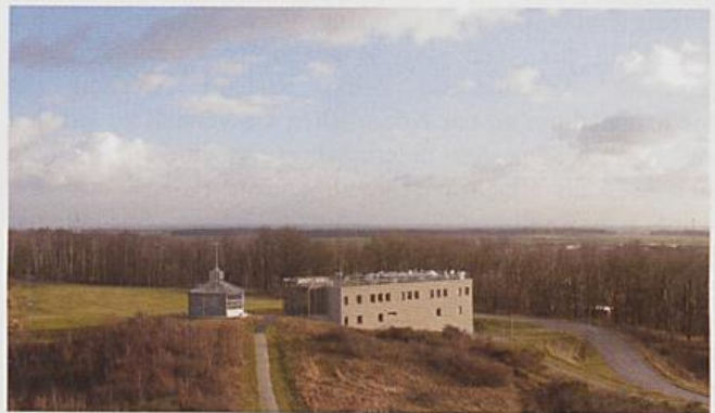
Abb. 1.4: Windenhaus mit dem Gebäude der Strahlungsmesszentrale 2004
