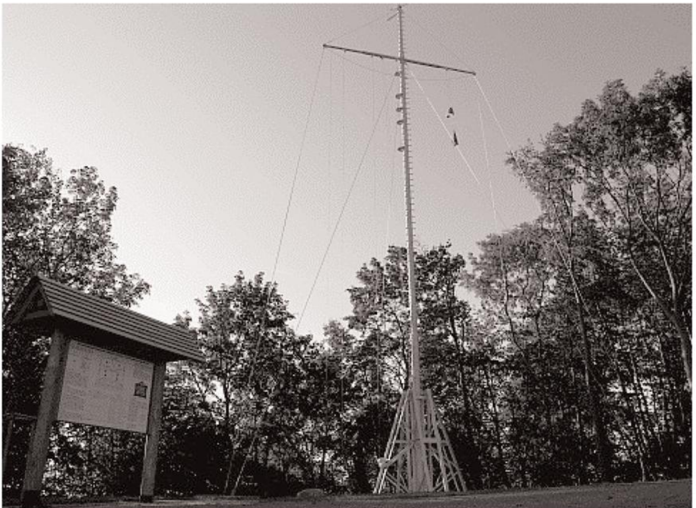
Anlage im September 2009
