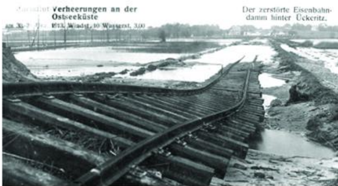
Abbildung 1: Zerstörter Eisenbahndamm bei Ückeritz. Figure 1: Destroyed railway embankment in Ückeritz. Quelle/source: http://www.die-wetterversicherung.de
