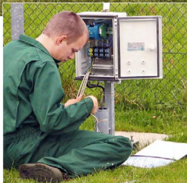
Techniker bei der Installation neuer Messgeräte
