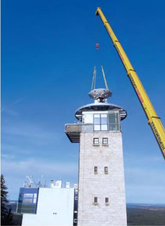
Installation des ersten neuen Radars im Projekt RadSys-E am Meteorologischen Observatorium Hohenpeißenberg im Dezember 2009
