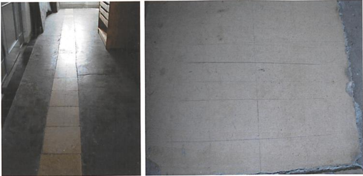
Abb. 6: Sonnenquadrant, Mittagslinie im 2. Stock des Pfarrhofes und Detail davon, in dem die Querlinien zur Festlegung der Mittagslinie mit dem Sonnenquadranten erkennbar sind.
