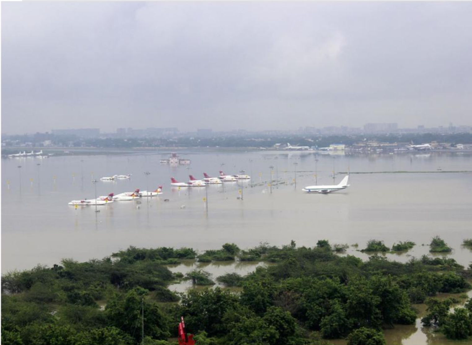
Der nach schweren Monsunregenfällen überflutete Flughafen Chennai in Südindien (Chennai International Airport; VOMM; 12,99° N; 80,18° E; 16 m MSL) am 2. Dezember 2015, ©Indian Air Force, GODL-India, https://commons.wikimedia.org/w/index.php?curid=45417328
