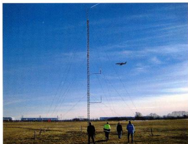
Messmast am Flughafen München
