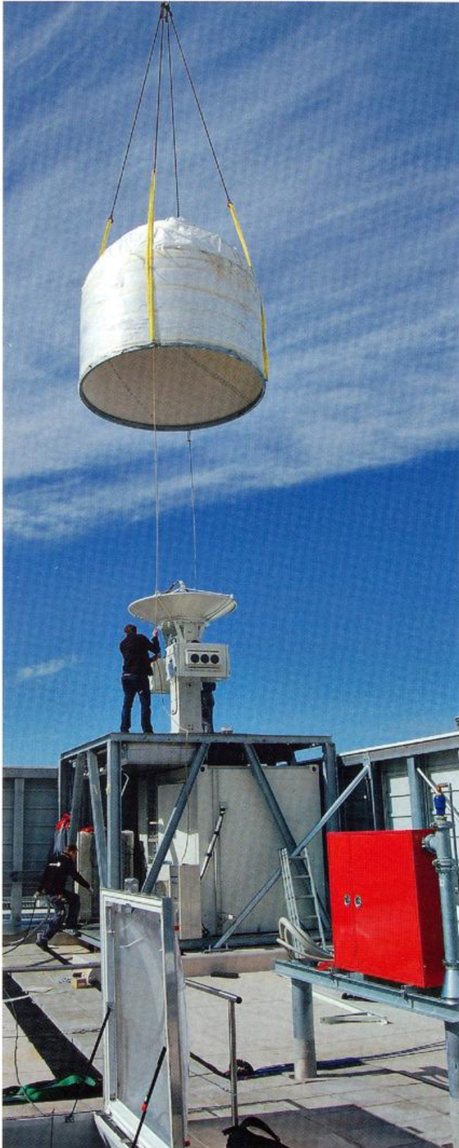
Geräteaufstellung (Lidar) am Flughafen München
