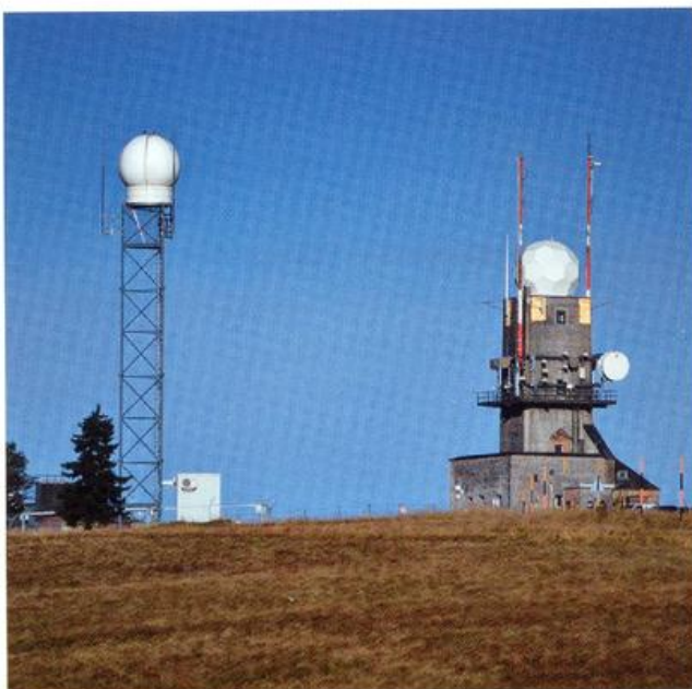
Ausfallsicherungsradar (links) und neues Verbundradar (rechts) am Standort Feldberg
