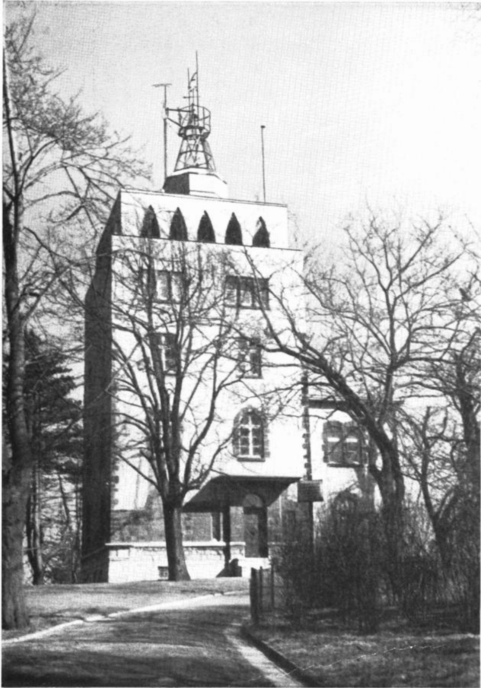
Das Meteorologische Observatorium in Aachen
