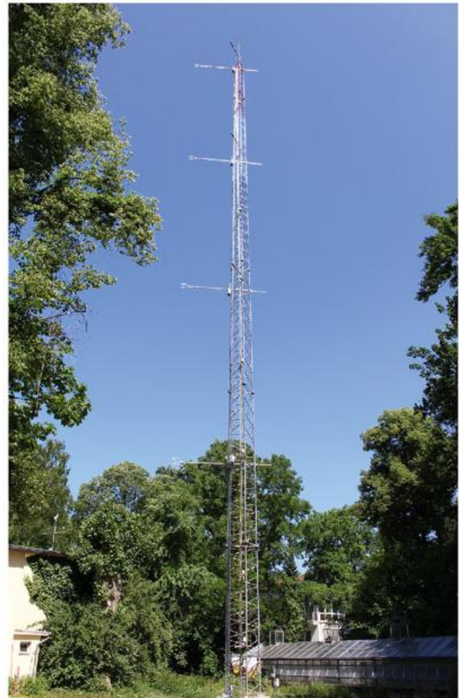
Abbildung 2-4: 40 m hoher Messmast mit Eddy-Kovarianz-Systemen und Vierkomponenten-Strahlungsflussmessungen in fünf unterschiedlichen Höhen sowie weiteren Messinstrumenten am Standort Rothenburgstraße des UCO Berlin (Foto: Fred Meier).
