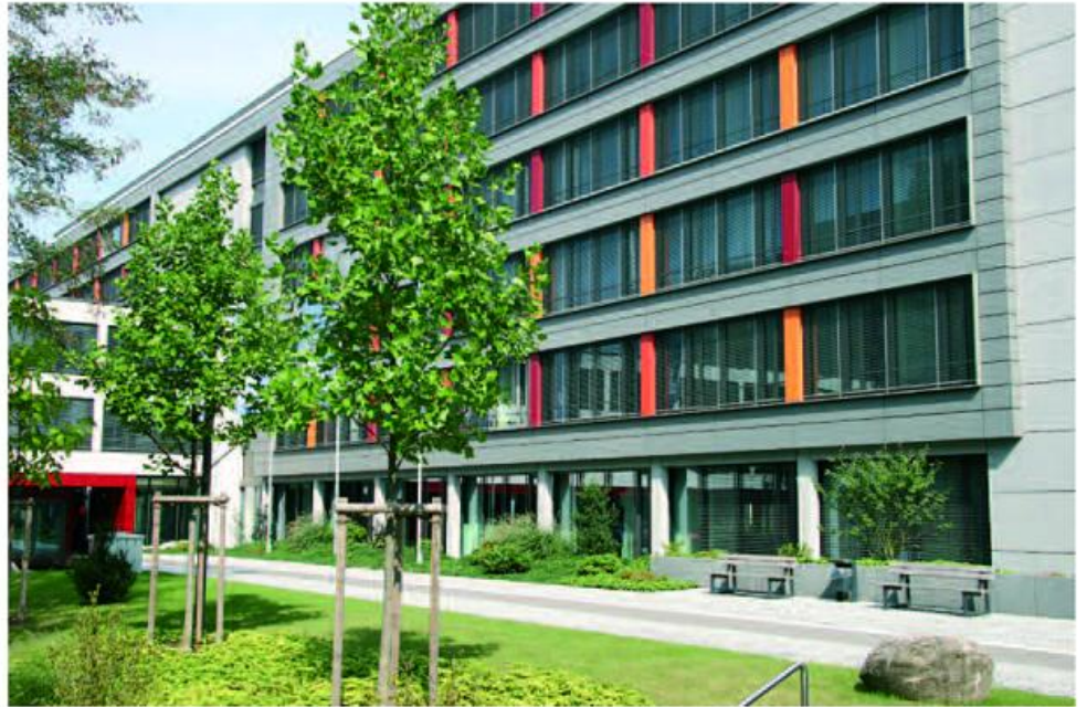
Der Bibliotheksflügel im Neubau der Zentrale des DWD in Offenbach
