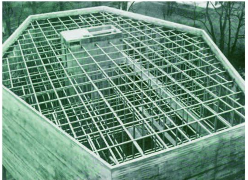
Rohbau des Magazins in Offenbach von oben, 1956
