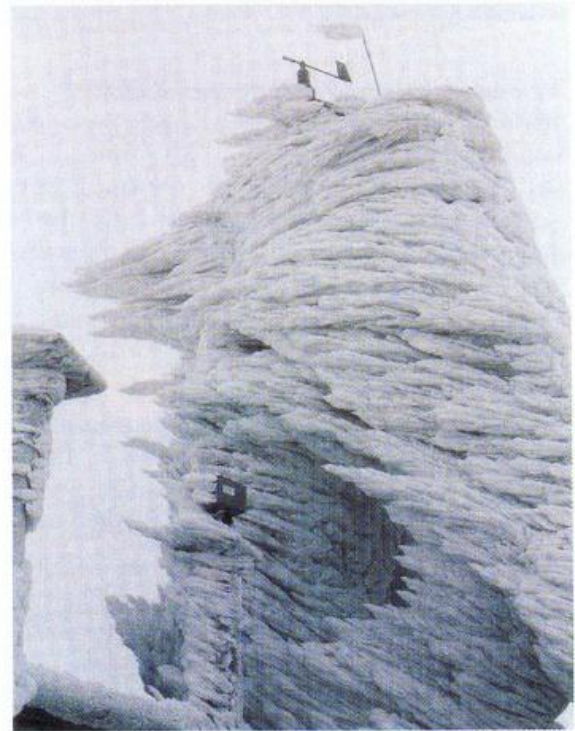
Winterlicher Raueisansatz am Anemometer auf dem Dach des Turmes
