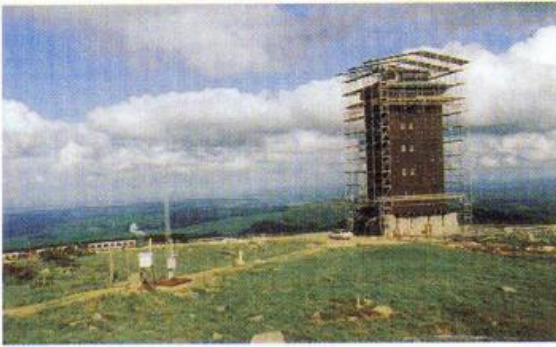
Eingerüsteter Turm mit provisorischem Dach, provisorisches Messfeld links im Bild
