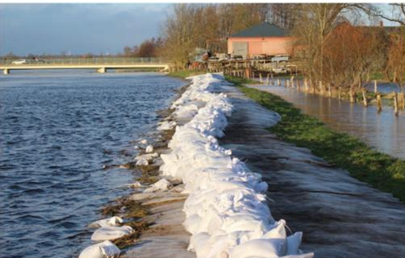
◀ Deichsicherung an der Treene. (Quelle: Eider-Treene-Verband)
