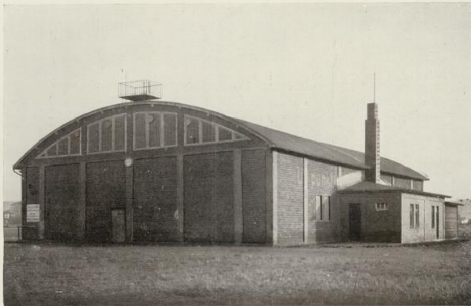
Flugzeughalle auf dem St. Arnualer Flugplatz. Im Hintergrund der Windgeschwindigkeitsmesser von der Firma Richard.
