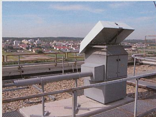
Abb. 17: Staubprobensammler mit einem Luftdurchsatz von ca. 1000 m 3 /h
