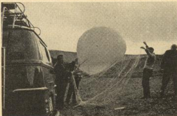
Abb. 16 Start einer „gefesselten“ Radiosonde
