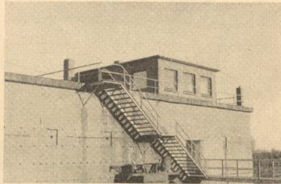
Abb. 3 Aufgang zur Wetterstation Emden auf dem Bunker an der Nesserländer Schleuse
