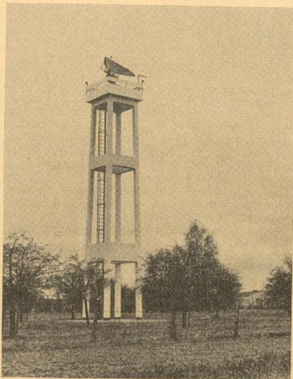
Abb. 7 Wetter-Radargerät Decca-41 auf einem 17 m hohen Turm bei der Flugwetterwarte Stuttgart-Echterdingen
