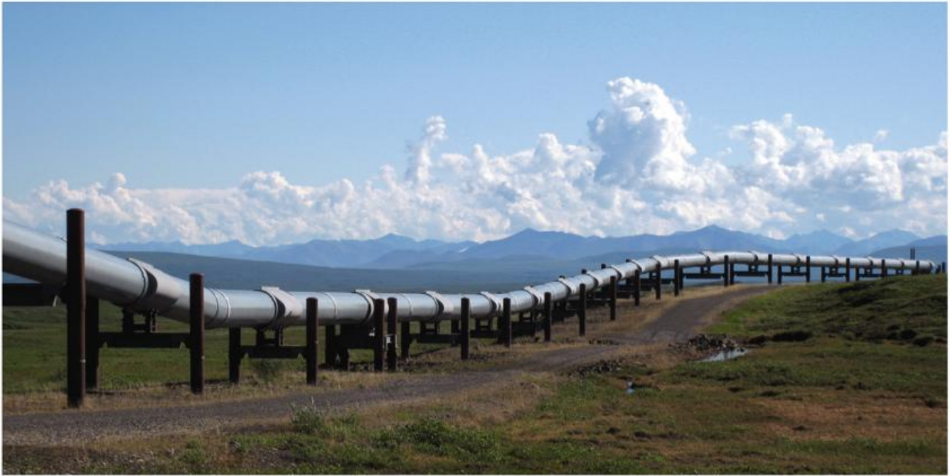
Abb. 7-1: Alaska-Pipeline im kontinuierlichen Permafrost des North Slope mit der südwärts zu überquerenden Brooks Range im Hintergrund. Aufnahme: Wilfried Haeberli, Juni 2008.
