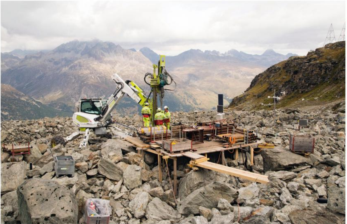
Abb. 7-6: Bohrung mit dreifach Kernrohr und Kaltluftspülung am Blockgletscher Murtèl-Corvatsch für Bohrkernanalysen und die Fortführung der seit 1987 durchgeführten Langfristmessungen der Temperaturentwicklung im Permafrost. Aufnahme: Alexander Bast, 15. September 2015.
