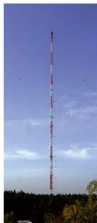
Abb. 4: 200 m hoher Messmast auf dem Gelände des Forschungszentrums Karlsruhe. An ihm sind in bis zu 10 Höhen Messwertgeber für Windrichtung und -geschwindigkeit, Temperatur und Taupunkt sowohl für mittlere Größen als auch für turbulente Schwankungen installiert.
