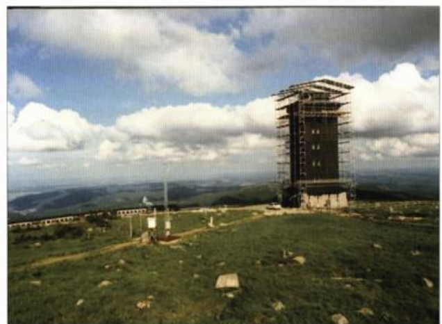
Abb. 16: Die eingerüstete Wetterwarte 1997 mit provisorischem Dach und Messfeld (vorne links im Bild) (Quelle: Peter-René Sosna)
