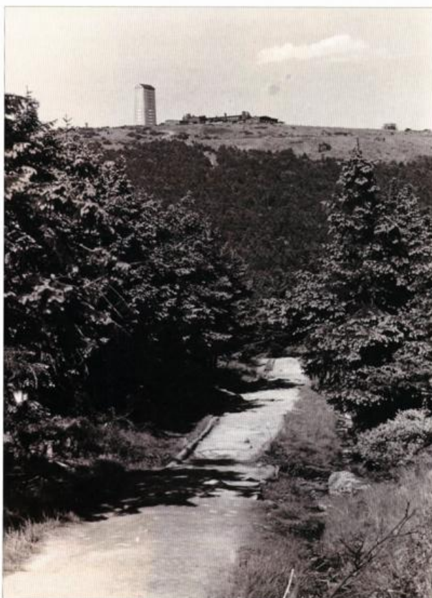
Abb. 18: Blick vom alten Goetheweg (auf dem Königsberg) zum Brocken, um 1937/38. Rechts ist zu sehen, dass das neue Gebäude für die Wetterwarte gerade im Bau ist. (Quelle: Archiv Familie Kinkeldey)
