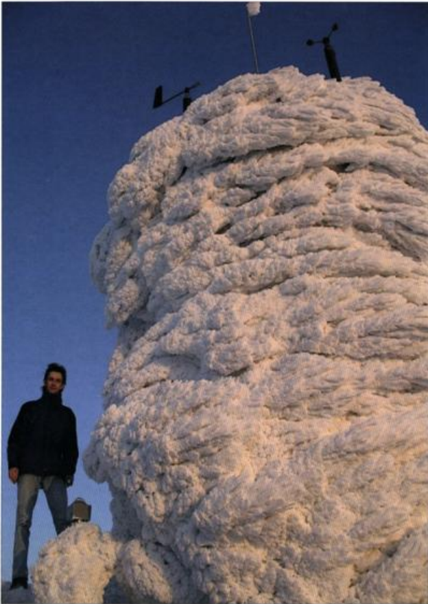
Abb. 4: Bis zu 300 cm starke Eisablagerungen am Windmast auf dem Dach der Wetterwarte Brocken mit Beobachter Marc Kinkeldey zum Vergleich, aufgenommen am 18. März 2006 (Quelle: Marc Kinkeldey)
