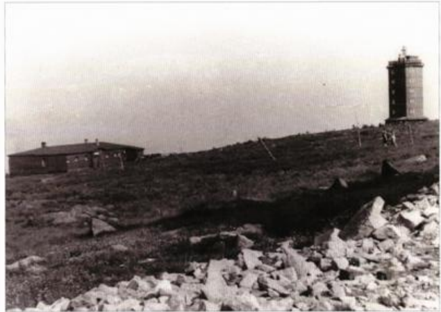
Abb. 9: Die neue Wetterwarte Brocken nach ihrer Fertigstellung 1939 (Quelle: Werner Hartmann, Halberstadt)
