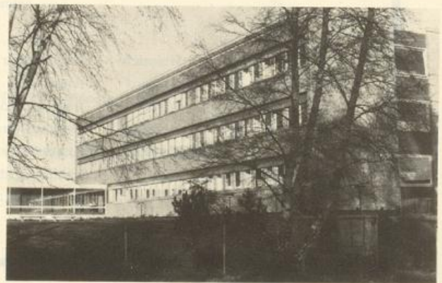
Abb. 2: Neubau des Meteorologischen Observatoriums Hamburg
