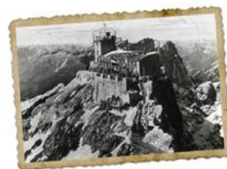
Wetterstation Zugspitze, historisches Münchner Haus (Bild: DWZ)
