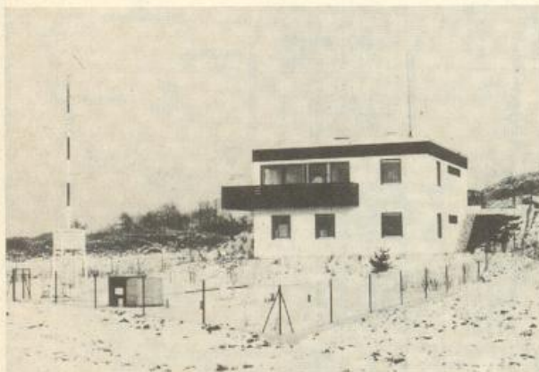
Abb. 4: Neubau der Wetterstation Regensburg
